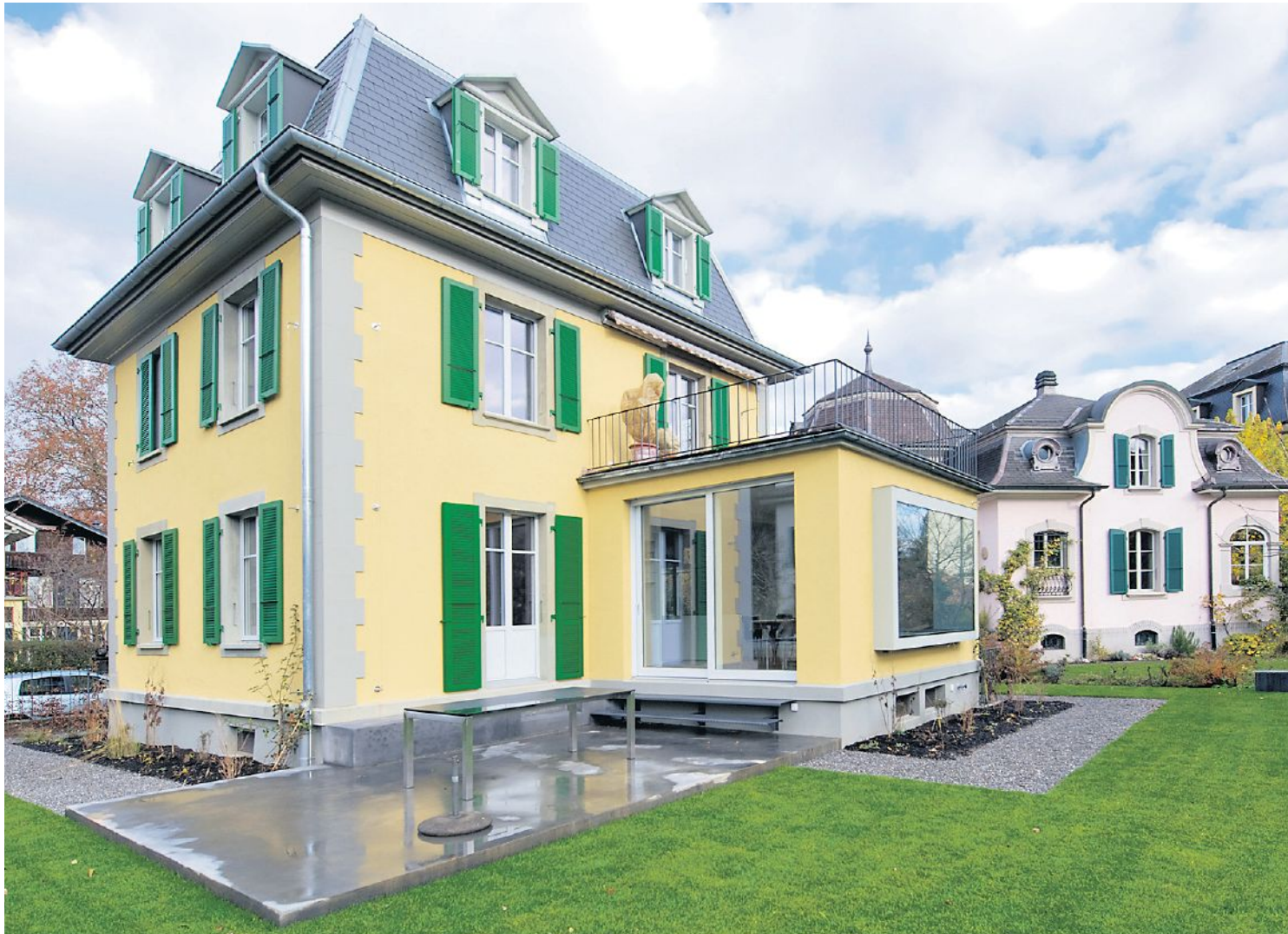
Berner Zeitgeschichte: Das 1893 erbaute Haus hat seine ursprüngliche Erscheinung wiedererlangt
