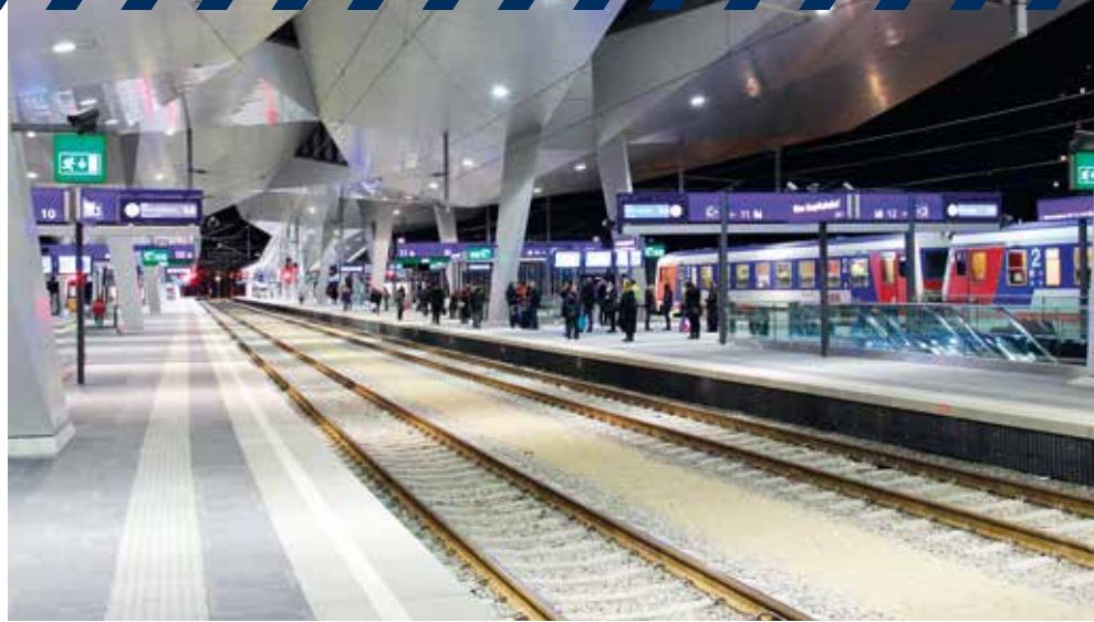
Hauptbahnhof: Eines der jüngsten Prestigeprojekte im Stahlbau – das Rautendach
