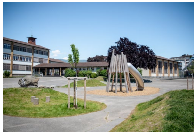
Illustrations proposées par Julie Riedo : Projet de transformation du préau de l'école Fontenay, Yverdon-les-Bains, 2021 Photographies de la démarche participative, du chantier participatif et du préau ouvert par Zoé Jobin
