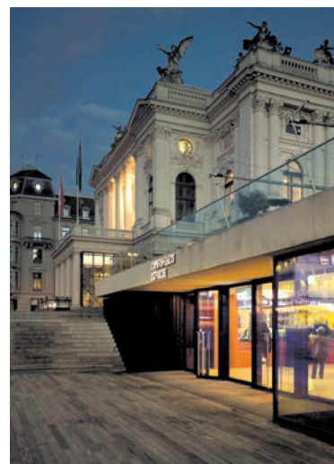
Der Eingang zu den Billettkassen des Opernhauses ist neu gestaltet.
