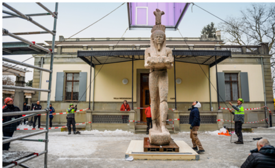
Die Statue des Gottes Hapi steht auf ihrem vorgefertigten, beheizbaren Fundament. Im Anschluss wird die vorab gefertigte Haube aus Sicherheitsglas montiert.
