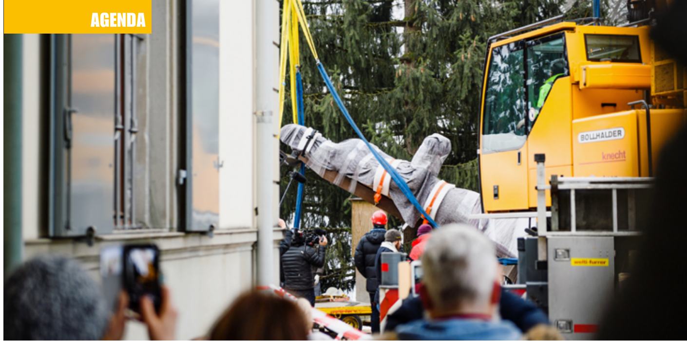
Nach dem Antransport auf einem Tieflader und der Montage in einem extra errichteten Zelt wird die Statue mithilfe zweier Kräne behutsam aufgerichtet.
