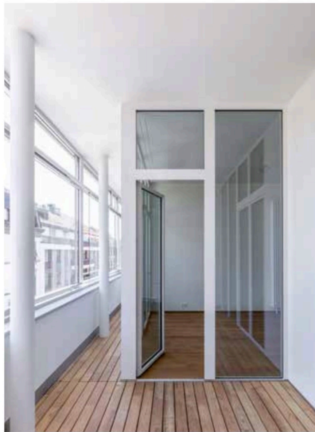
2 Durch die zweite, gedämmte Wand konnte die Fassade im Originalzustand erhalten bleiben; im Zwischenraum entstand eine Loggia. Grâce au deuxième mur isolé, la façade a pu être conservée dans son état d'origine; une loggia a été créée dans l'espace intermédiaire. Grazie alla seconda parete isolata, la facciata è stata conservata nel suo stato originale e nello spazio intermedio è stata creata una loggia.
