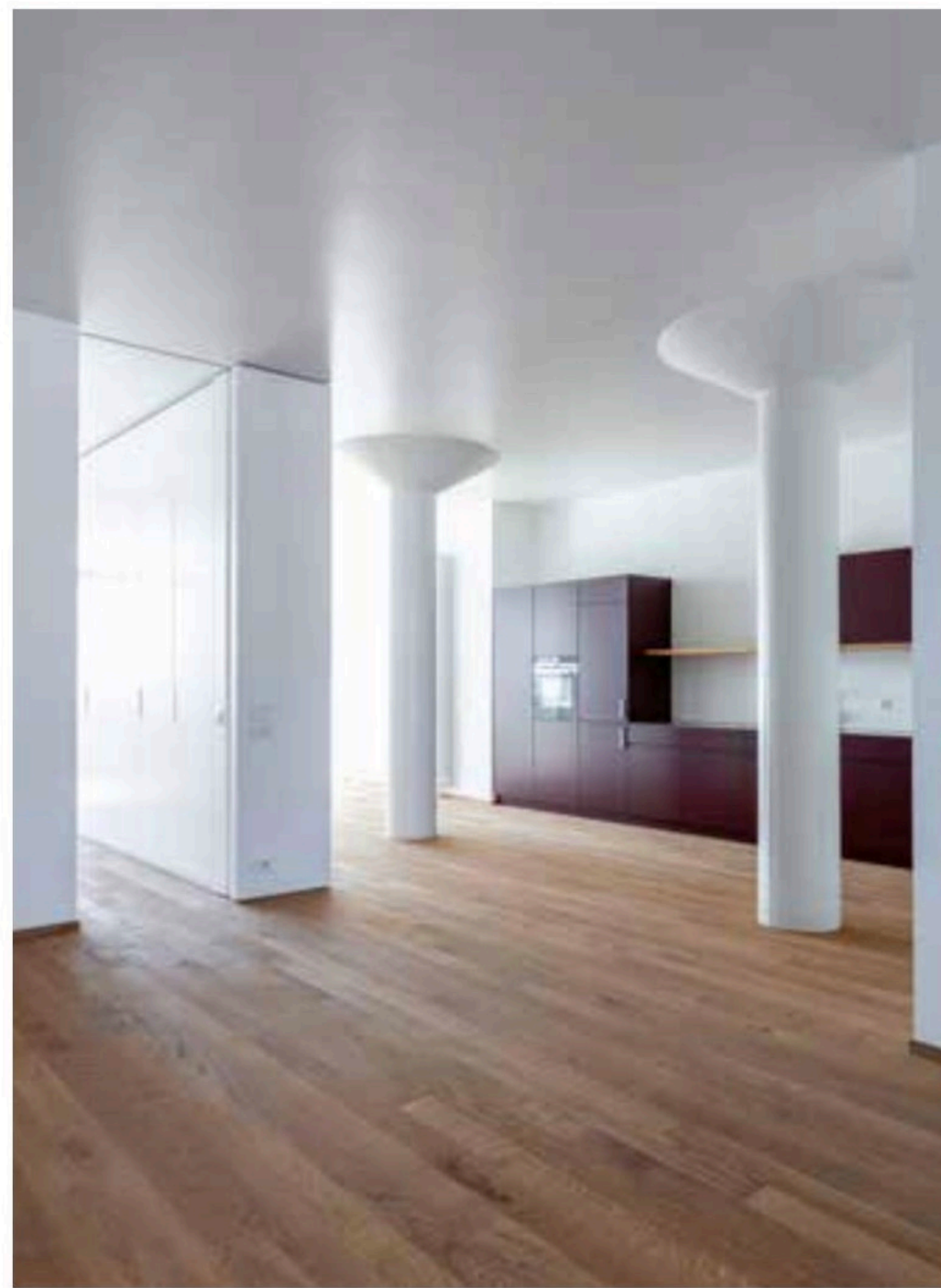
3 Die Anhebung des Bodens ermöglichte es, die Pilzkopfstützen sichtbar zu belassen. L'élévation du sol a permis de laisser les «chapiteaux» des dalles champignons visibles. Il pavimento è stato rialzato per lasciare visibili i «capitelli» delle colonne a fungo.
