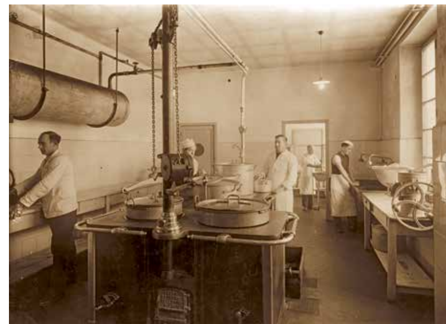
Die Planung umfasste nicht nur die städtebauliche Anordnung und die Gebäude, sondern ebenso alle Infrastrukturen, die für die Stadt nötig waren. Die Bauzeit dafür betrug lediglich 547 Tage.
